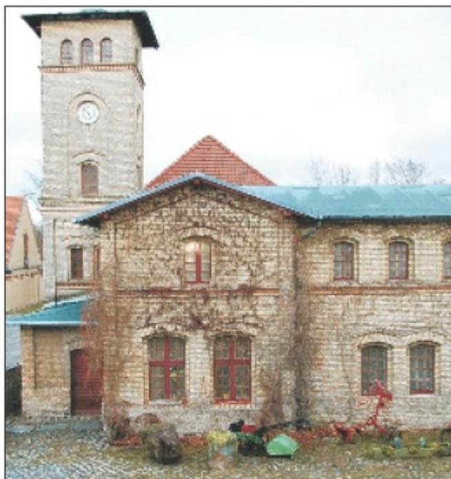
Durch den Umbau zum „Kulturzentrum Gutshof“ soll der alte Gutshof Britz aufgewertet werden. Insgesamt acht Millionen Euro veranschlagt das Bezirksamt dafür. Foto: Claudia Pfister
